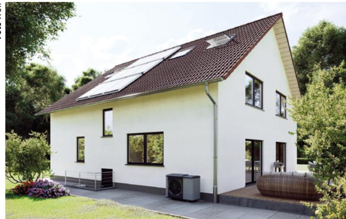
Eine Vorlauftemperatur von 55 °C ist vollkommen ausreichend und bestens geeignet, Heizkörper eines Bestandsbaues zu versorgen.
