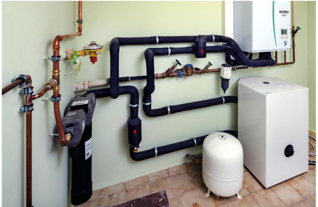
Im Technikraum steht ein kompaktes Hydromodul mit anschlussfertigen Komponenten sowie ein Speichermodul als Pufferspeicher zur Verfügung.
